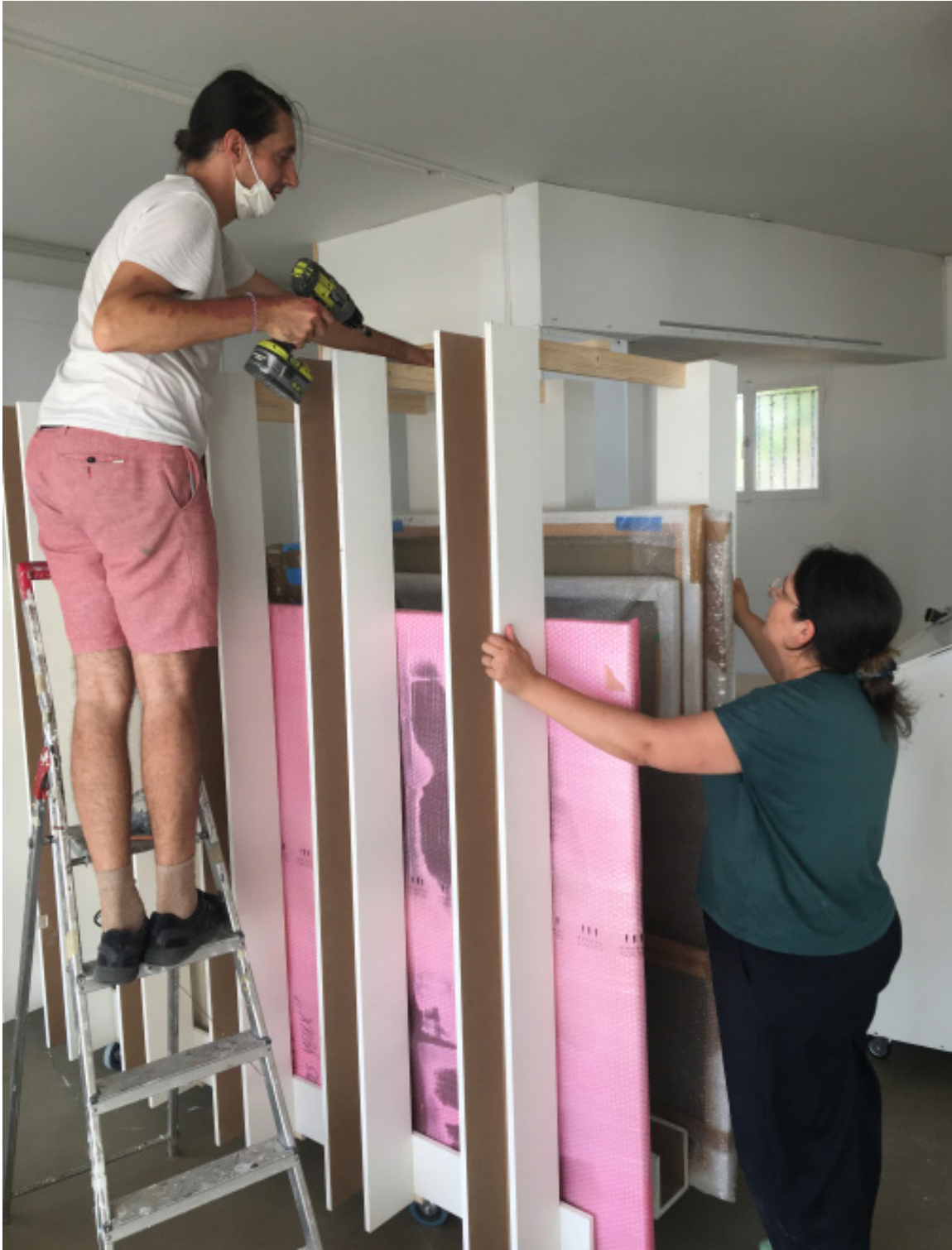
Construction du mobilier, juillet 2020. © collectif W
