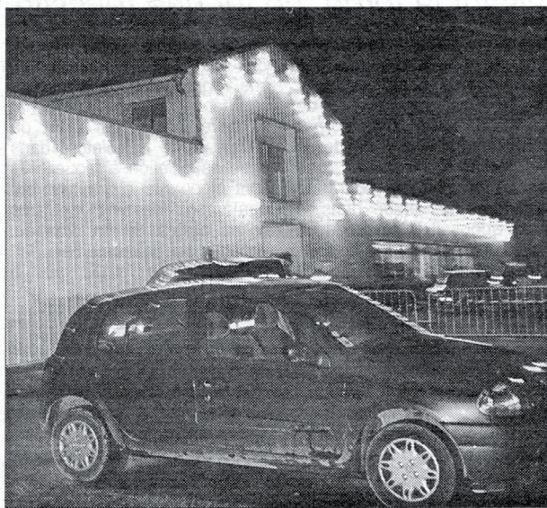
Le gymnase illuminé.
